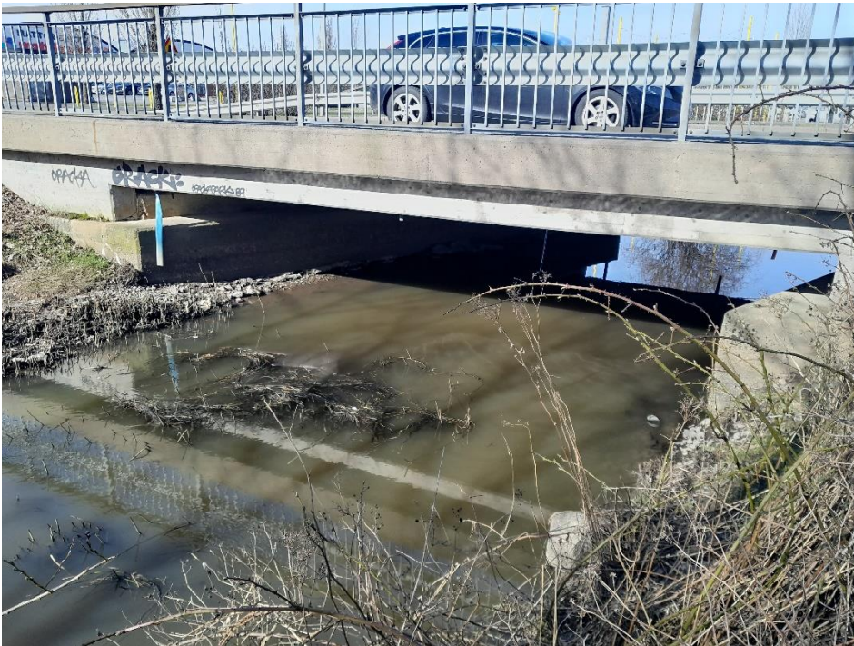
Figur 8. Färgfabriksbron över Kvillebäcken
